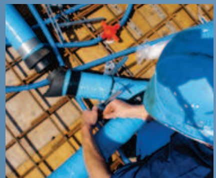
❸ Ausrichten, befestigen der Varioplate, fertig
