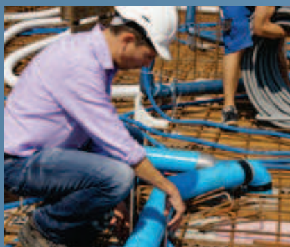
❷ Befestigen der Ablaufrohre mit Spannbund
