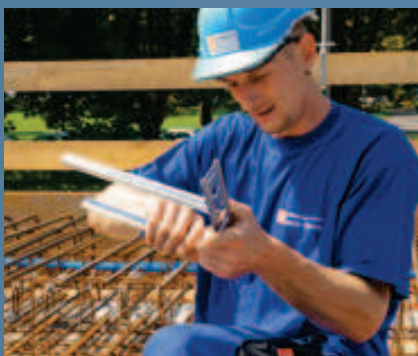
❶ Zusammenstecken der Füsse auf Varioplate
